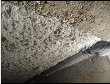
Photo N° 1039 ECH-N°1 FLOCAGE - -COULOIRS DE CAVES Plafonds Flocage
